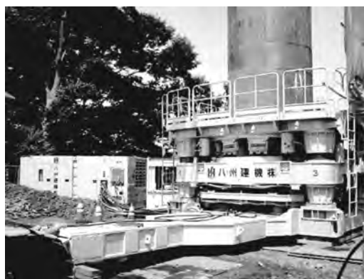
〈写真1. 現場施工中のRT-300Ⅲ〉
