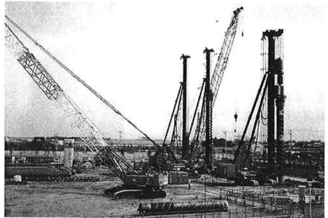
鋼管矢板打設工事全景
