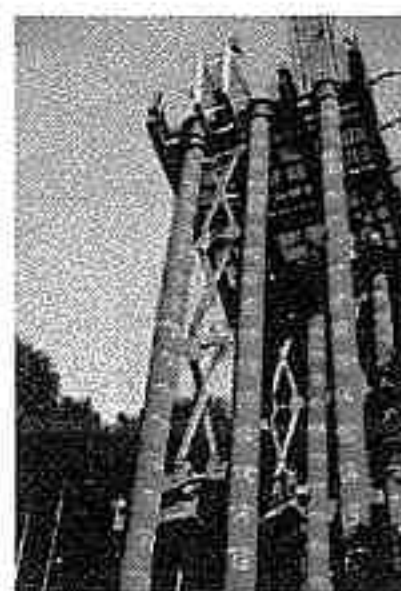
杭間建て込み
