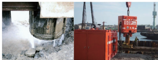
先行杭(写真③)
