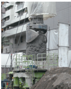
障害物撤去状況
