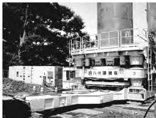
〈写真1. 現場施工中のRT-300Ⅲ〉
