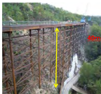
新名神高速道路 坊川第三橋工事 現在施工中
