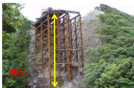
近畿自動車道 紀勢線黒崎トンネル工事 平成25年度完成
