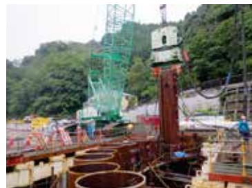
④パイロハンマでの鋼管矢板の建込み状況
