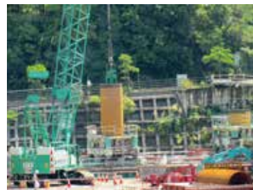
②全周回転オールケーシング掘削機での先行掘削状況
