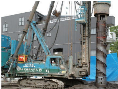
写真-1 施工状況写真
