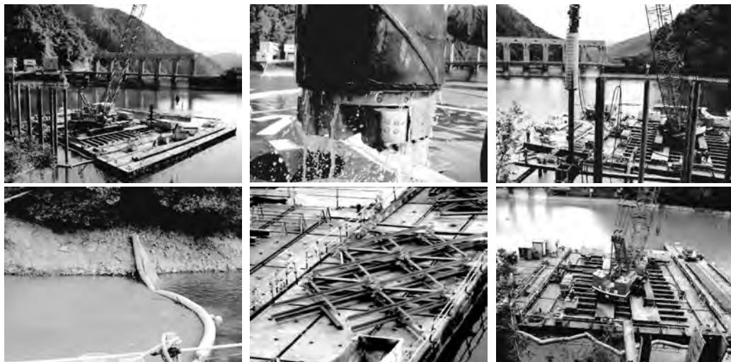
最小限に抑えると共に、ダム湖内での施工となるので、打設中に発生する汚濁が拡散しないように汚濁防止膜で周囲を取り囲み、スライム受ベッセルにて残土水を集積し、周囲への濁りの影響がないようにしています。尚、油資類は動植物に影響が無い自然分解性エコオイルを使用しました。
