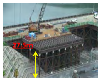
津軽ダム 上流構台C工区設置他工事 平成25年度完成
