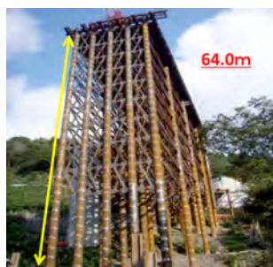
富山利賀ダム 庄川橋梁下部工事 平成20年度完成
