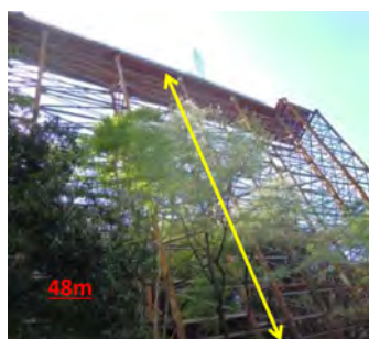
新名神高速道路 切畑トンネル 平成25年度完成
