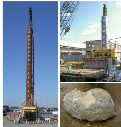
写真2 施工状況と掘削された石灰石
