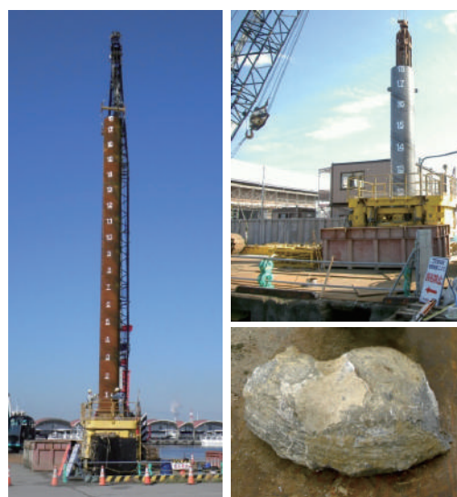
写真2 施工状況と掘削された石灰石
