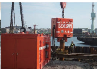
杭打機本体(写真④)
