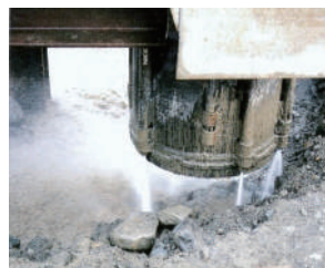
先行杭(写真③)
