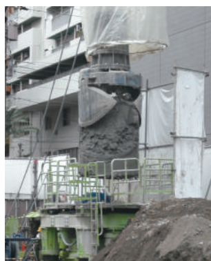
障害物撤去状況
