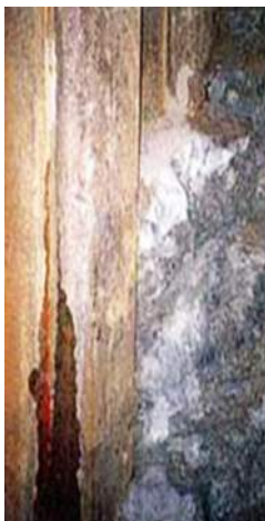
鋼矢板 軟岩貫入状況 (写真②)
