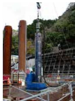
④パイロハンマでの鋼管矢板の建込み状況
