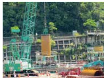
③ダウンザホールハンマでの補助削孔状況
