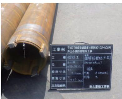
写真1 先端ビット付鋼管杭
