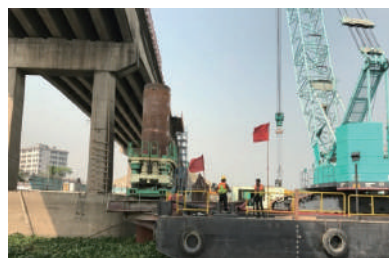
障害撤去状況(カチプール橋)
