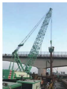
パイプロ打設状況
