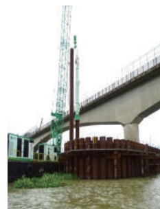
油圧ハンマ打設状況
