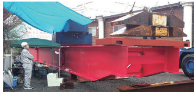
第1回载荷試験の状況
