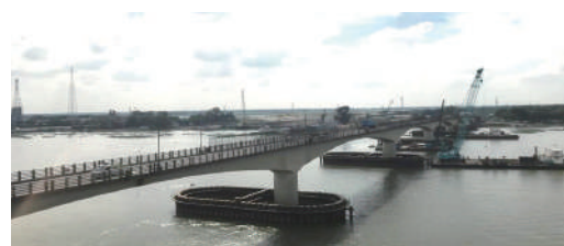
グムティ橋(鋼管矢板打設完了)
