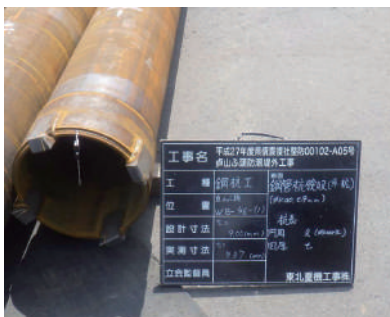
写真1 先端ビット付鋼管杭
