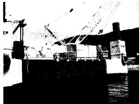
SEPでの施工状況
