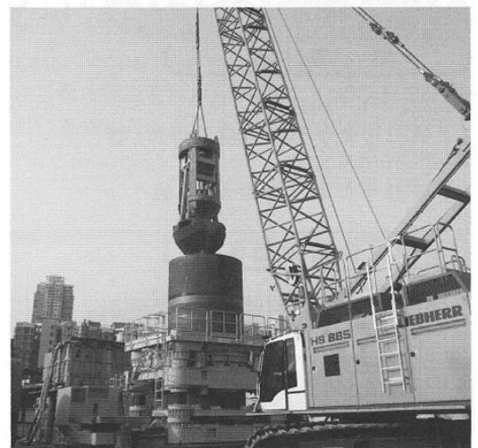
〈写真3. 施工中のRT-320H〉
