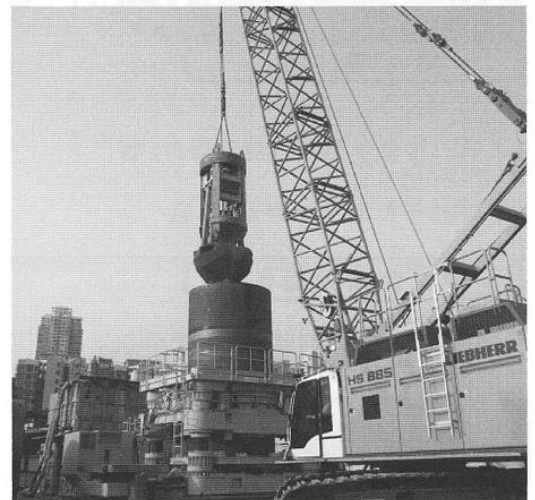
〈写真3. 施工中のRT-320H〉
