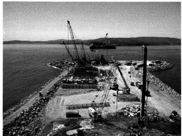
施工状況写真
