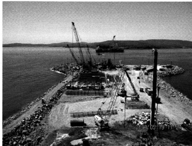
施工状況写真
