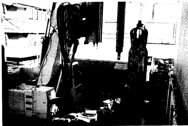
マルチドリルによる施工状況
