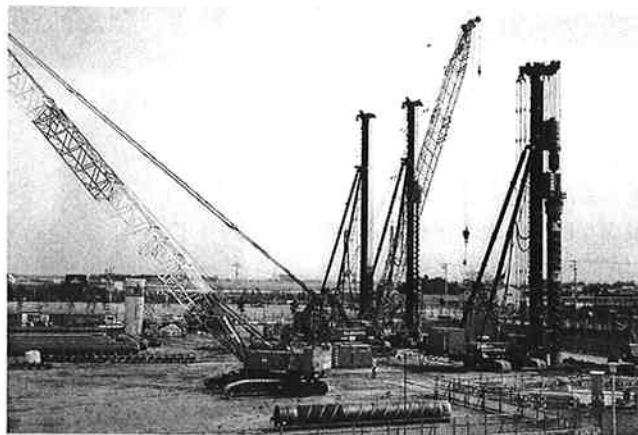
鋼管矢板打設工事全景
