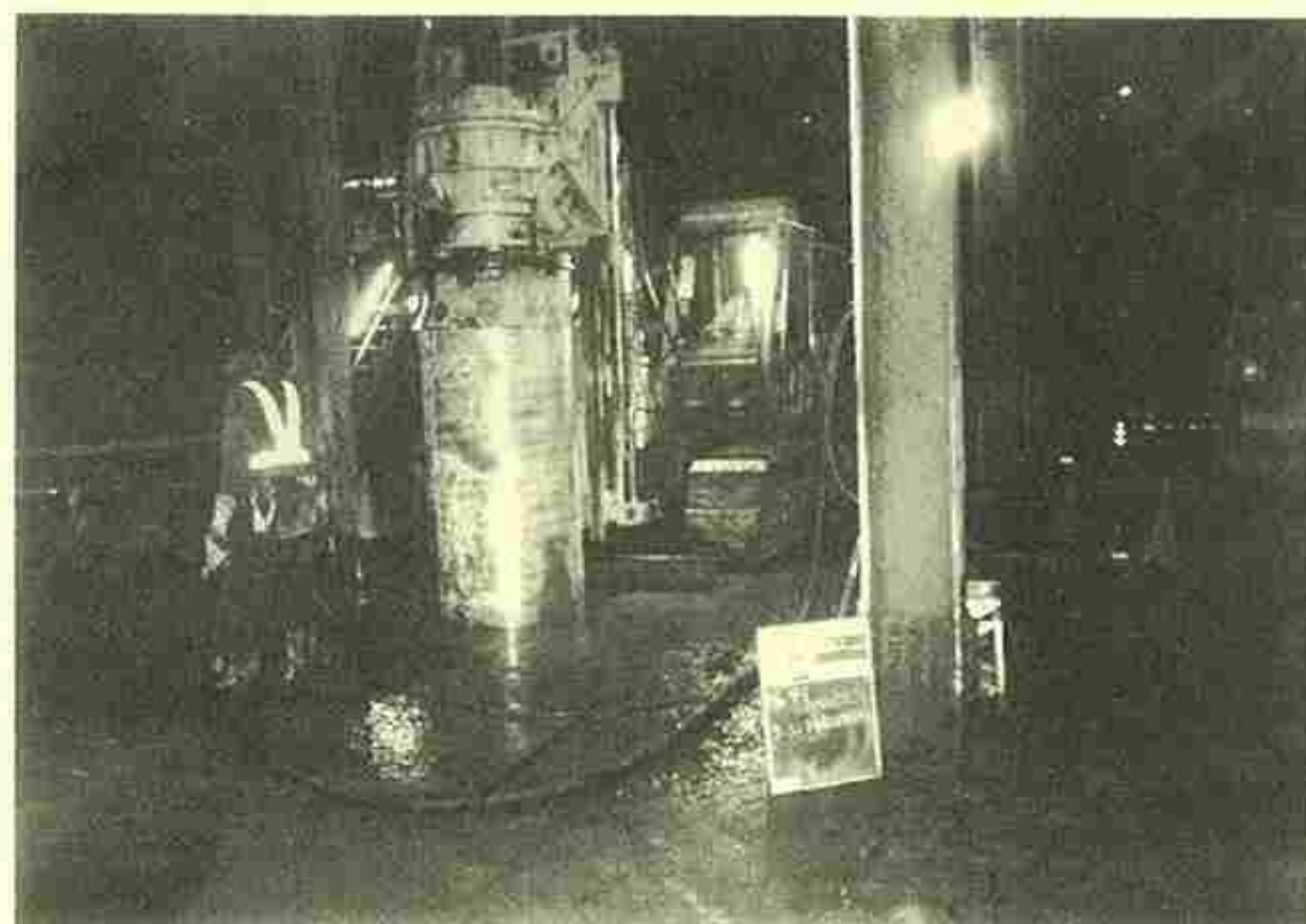
BG機施工状況
