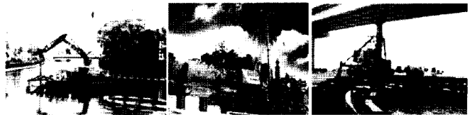
④水陸両方リーダレス杭打機
