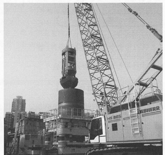
〈写真3. 施工中のRT-320H〉
