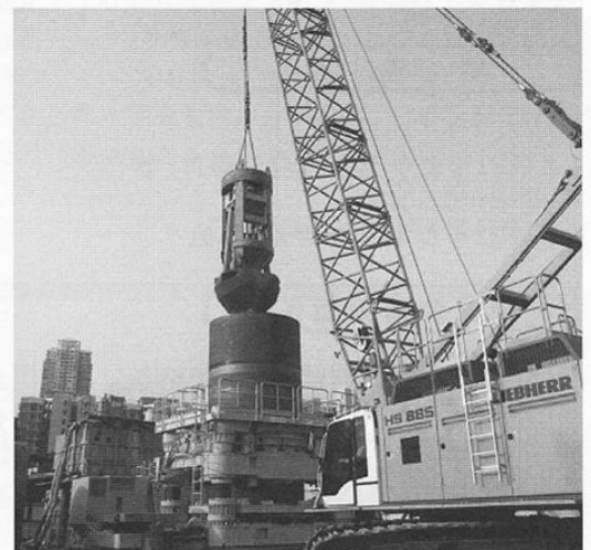
〈写真3. 施工中のRT-320H〉
