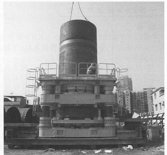
〈写真2. 施工中のRT-320H〉
