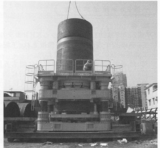
〈写真2. 施工中のRT-320H〉
